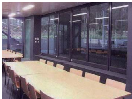
可動間仕切り設置
